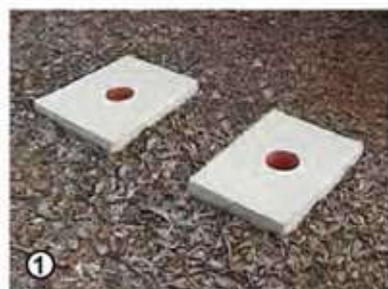
In der Praxis bestens bewährt haben sich **Köcherfundamente mit Leerrohren** ①. An Stelle der Schildpfosten wird ein im Durchmesser größeres Leerrohr aus Kunststoff einbetoniert (Baumarktabflußrohr).
