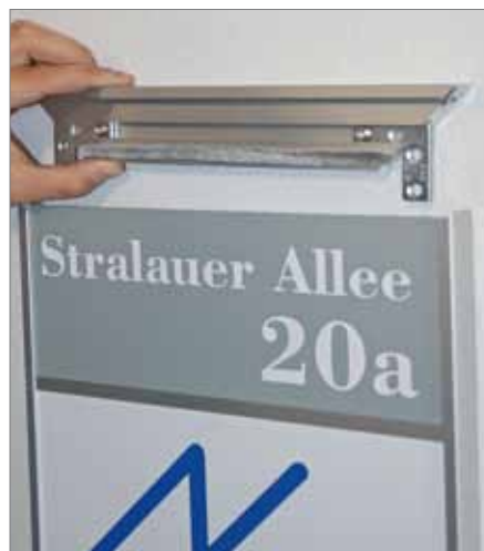
... das obere Profilteil entnehmen ...
